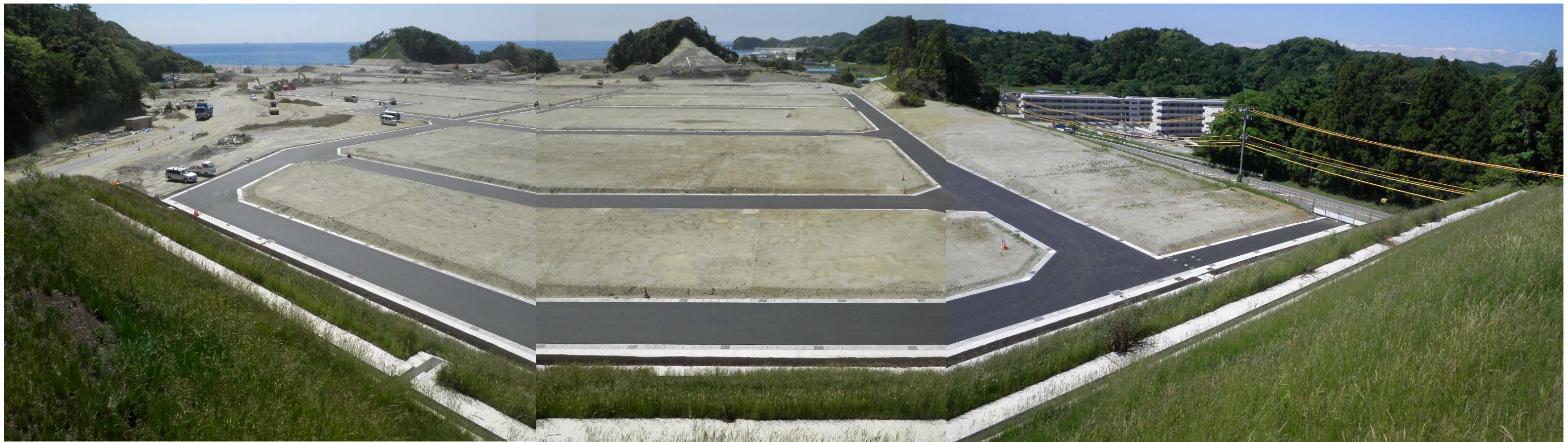
街区整備(北側高台北側)
