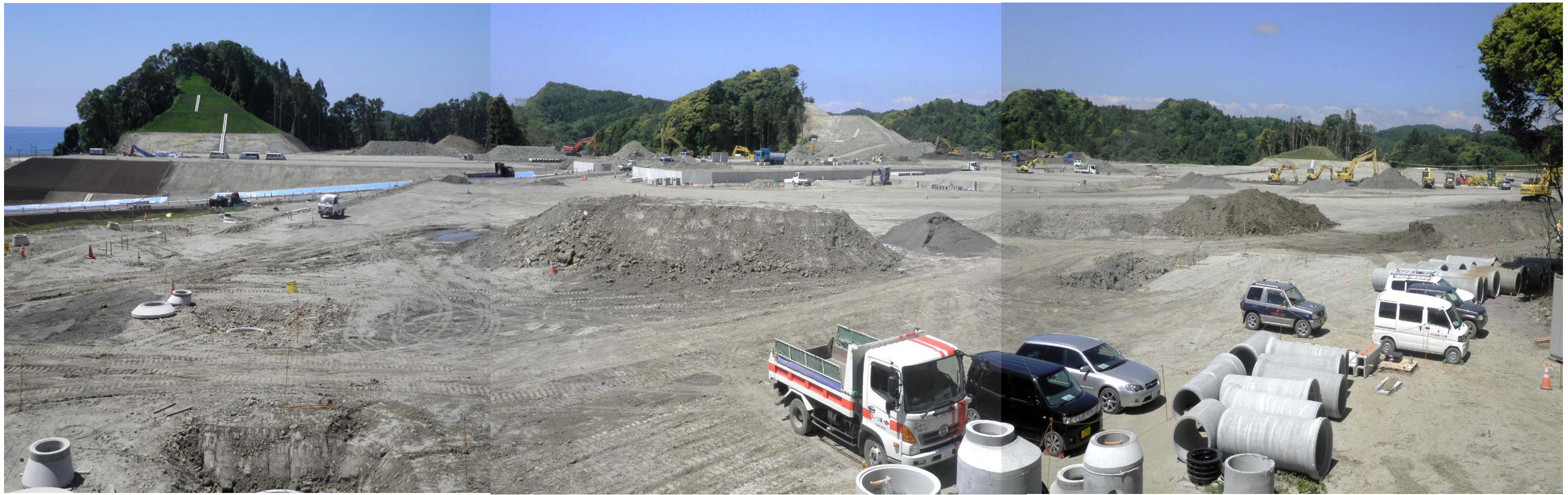
北側高台掘削
