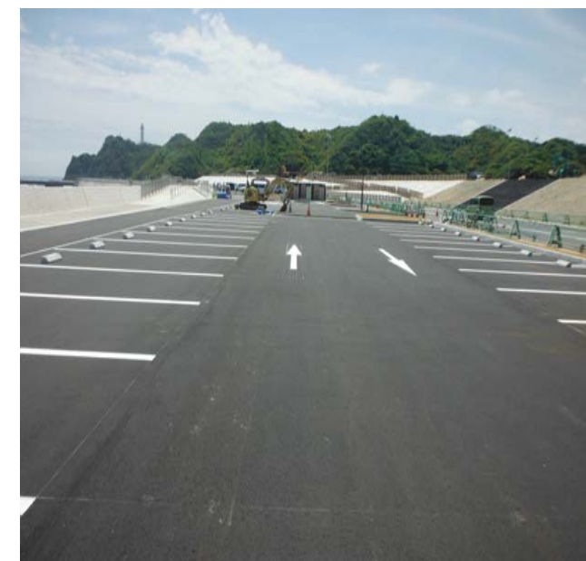
舗装完成状況
