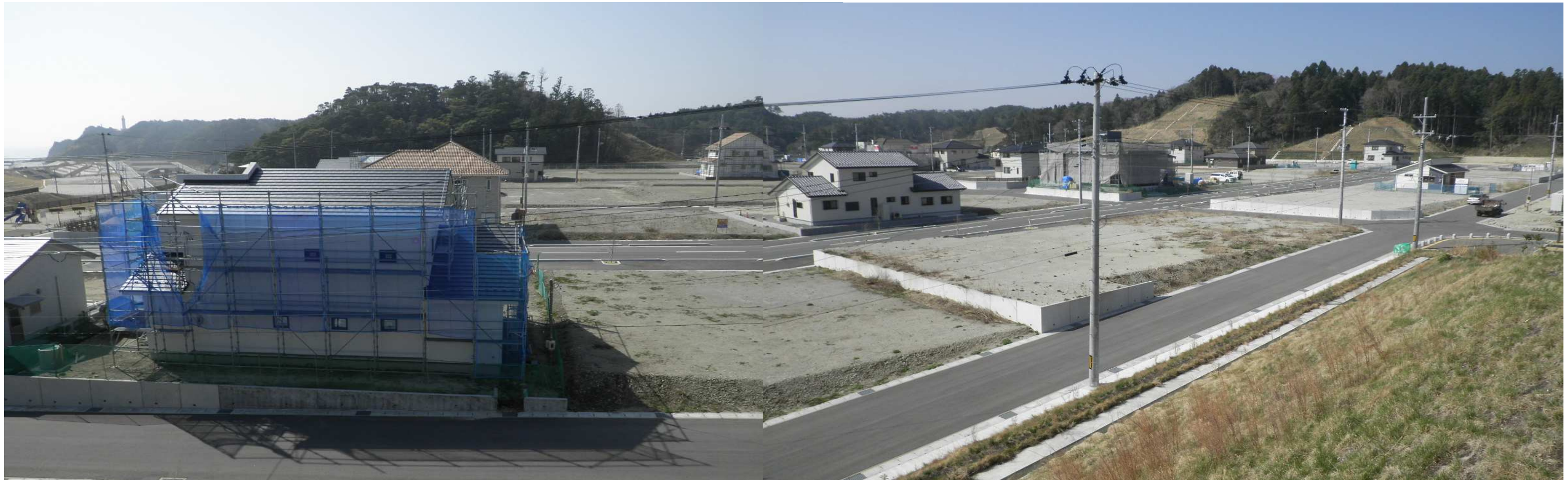
宅地状況(高台南側)
