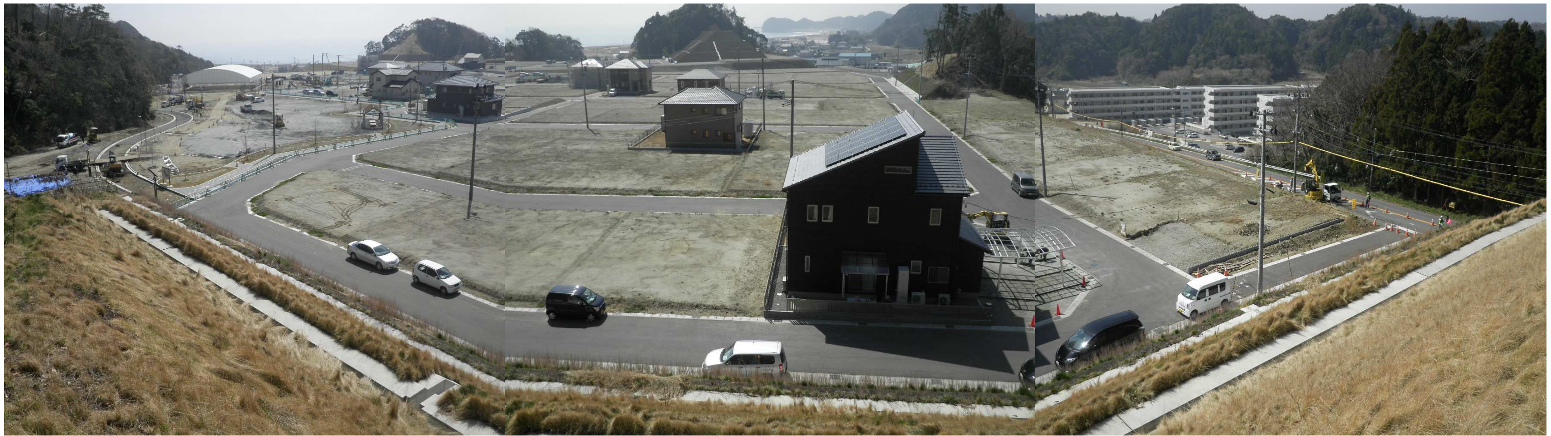
宅地状況(北側高台北側)
