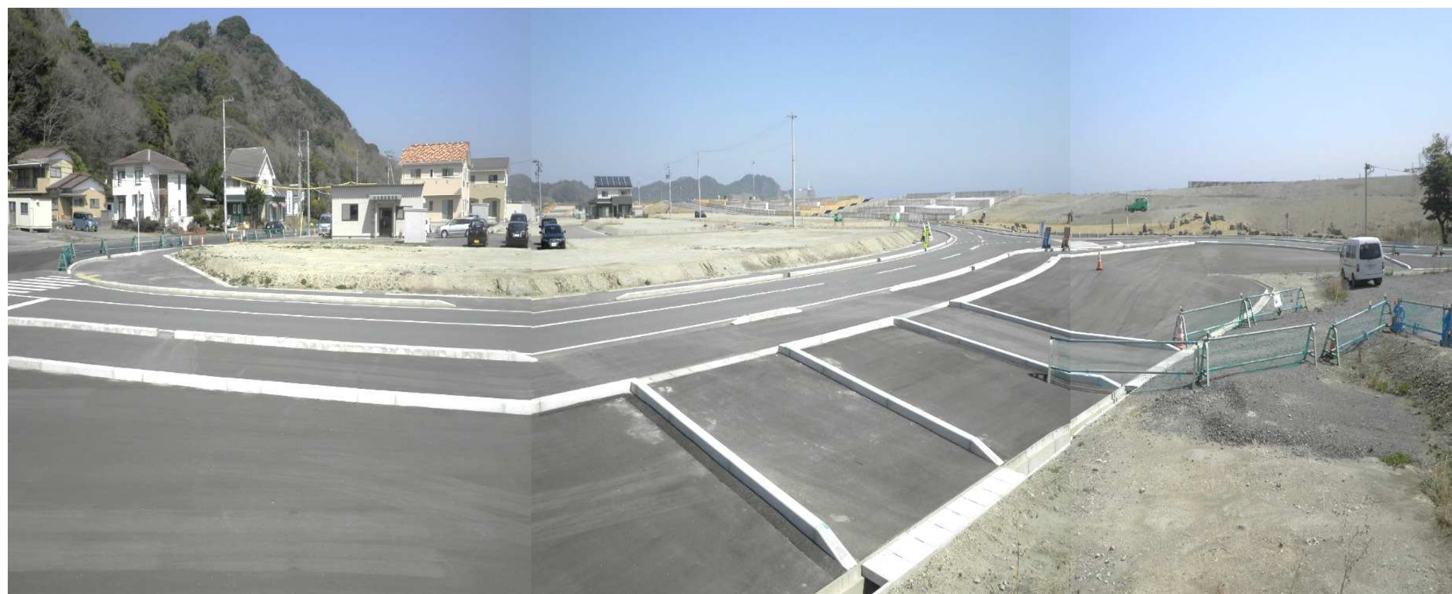
⑱ 南側平場(杉ノ塩屋崎北側)
